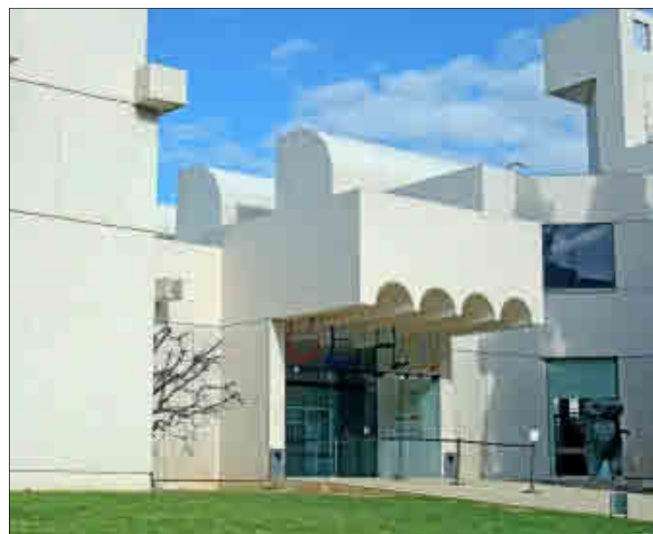
Fachada de la Fundació Miró. EL MUNDO
